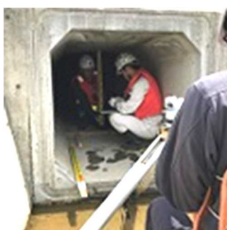
水路の変位測定
