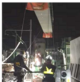
電車の橋を 架け替え
