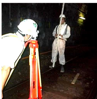
鉄道トンネルで レールの標高を 測定
