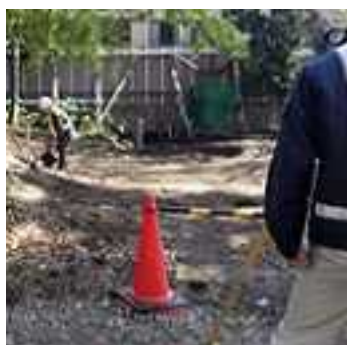
縁石敷設用 丁張設置
